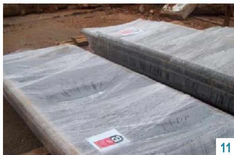
Figura 14 (cont. figura 13) Remoção de amianto não friável numa escola
