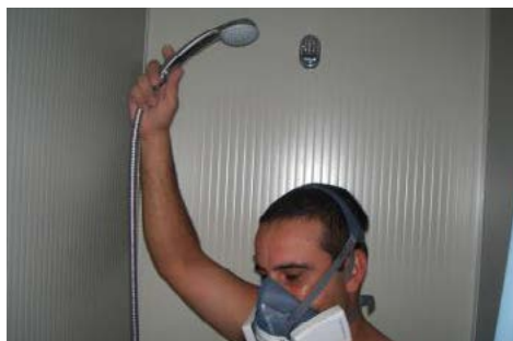
Figura 11 – Sequência para retirar os equipamentos de protecção individual, utilizados na remoção de amianto (fatos descartáveis, máscaras, óculos, luvas, botas e protecção de botas).
