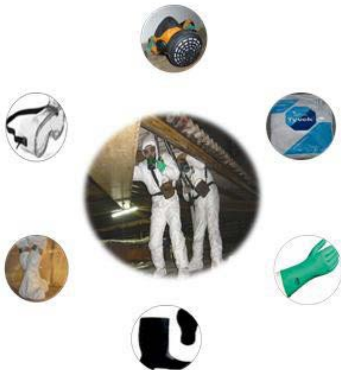
Figura 9 – EPI's, equipamentos de protecção individual, utilizados na remoção de amianto (fato descartável, máscara, óculos, luvas, botas e protecção de botas).
