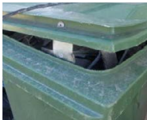
Figura 16 – Não conforme - Mal embalado, sem símbolo amianto aposto e escondido.
