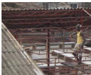
Figura 19 – Não conforme – Trabalhadores sem EPI's e sem protecções colectivas.
