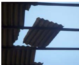
Figura 17 – Não conforme - Faltam obras conservação e chapa partida sem prancha.
