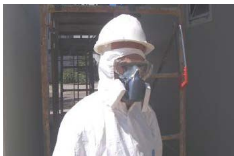
Figura 10 – Sequência para colocação dos equipamentos de protecção individual, utilizados na remoção de amianto (fatos descartáveis, máscaras, óculos, luvas, botas e protecção de botas).
