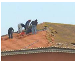
Figura 19 – Não conforme – Trabalhadores sem EPI's e sem protecções colectivas.
