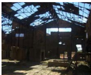
Figura 17 – Não conforme - Faltam obras conservação e chapa partida sem prancha.
