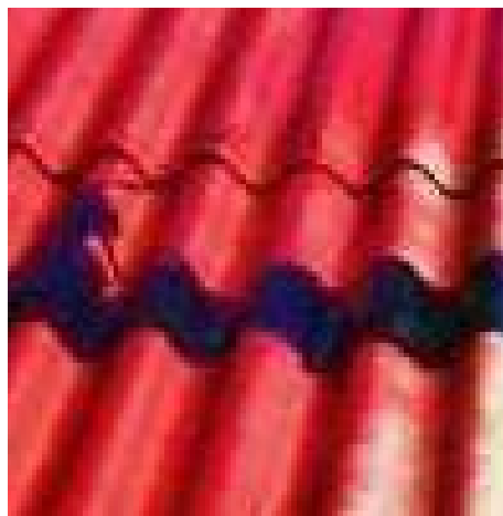
Figura 15 - Aspecto geral duma cobertura em fibrocimento com amianto, no processo de encapsulamento, com tratamento, limpeza e aplicação de sistemas de pinturas que impossibilitem a libertação de fibras de amianto.
