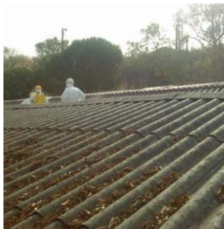
Figura 15 - Aspecto geral duma cobertura em fibrocimento com amianto, no processo de encapsulamento, com tratamento, limpeza e aplicação de sistemas de pinturas que impossibilitem a libertação de fibras de amianto.
