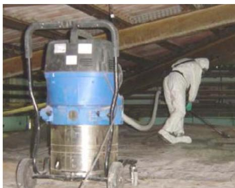
Figura 31 – Aspirador de partículas de alta eficiência, com filtros HEPA fabricados segundo as especificações internacionais relativas à utilização com amianto.
