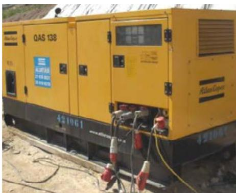
Figura 34 – Gerador de emergência para os casos de avaria ou de interrupção da rede eléctrica.
