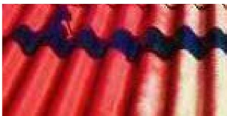
Figura 54 - Aspecto geral duma cobertura em fibrocimento com amianto, no processo de encapsulamento, com tratamento, limpeza e aplicação de sistemas de pinturas que impossibilitem a libertação de fibras de amianto.
