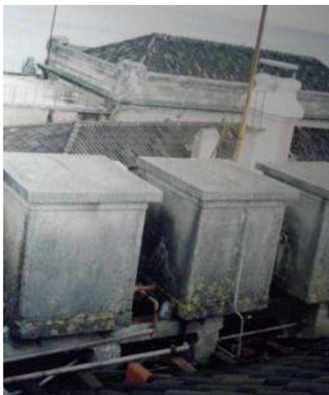
Figura 39 – Exemplo de uma situação que pode ser considerada um caso de exposições esporádicas e de fraca intensidade, com uma cobertura de fibrocimento até 75m<sup>2</sup> e depósitos em fibrocimento.
