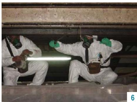
Figura 50 – Chapas e estrutura da cobertura, em fibrocimento com amianto, 2 – Humificação do fibrocimento com solução aquosa, 3 – Aspiração do desvão sobre a cobertura com recurso a aspirador de filtro absoluto, 4 – Monitorização das fibras e poeiras de amianto, 5 e 6 – Corte de grampos de fixação das chapas de fibrocimento.
