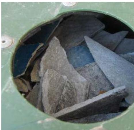
Figura 56 – Não, esconder fibrocimento com amianto.
