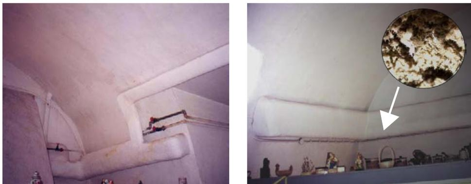
Figura 13 – Amianto em situação friável, em condutas de aquecimento.
