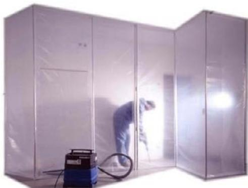
Figura 26 – Materiais de protecção contra a propagação da contaminação, em zona confinada, com amianto friável, com recurso a mangas plásticas.
