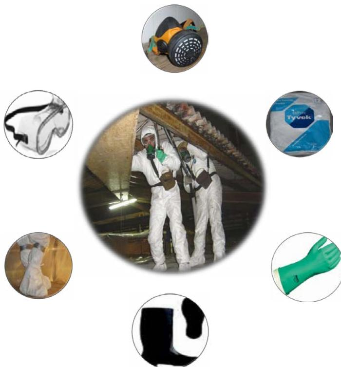
Figura 22 – EPI's, equipamentos de protecção individual, utilizados na remoção de amianto (fato descartável, máscara, óculos, luvas, botas e protecção de botas).
