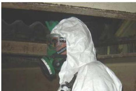
Figura 23 – Sequência para colocação dos equipamentos de protecção individual, utilizados na remoção de amianto (fatos descartáveis, máscaras, óculos, luvas, botas e protecção de botas).
